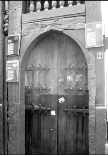
Abb. 3 Eine Ansicht der Tür des Hauses Wendelgasse 2 (Foto: W. Lückel)
