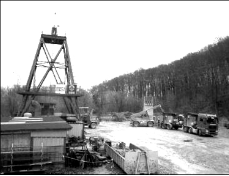
Abb. 1 Schachtverwaltungsbaustelle während des Einbaus der Asphalt dichtungen
